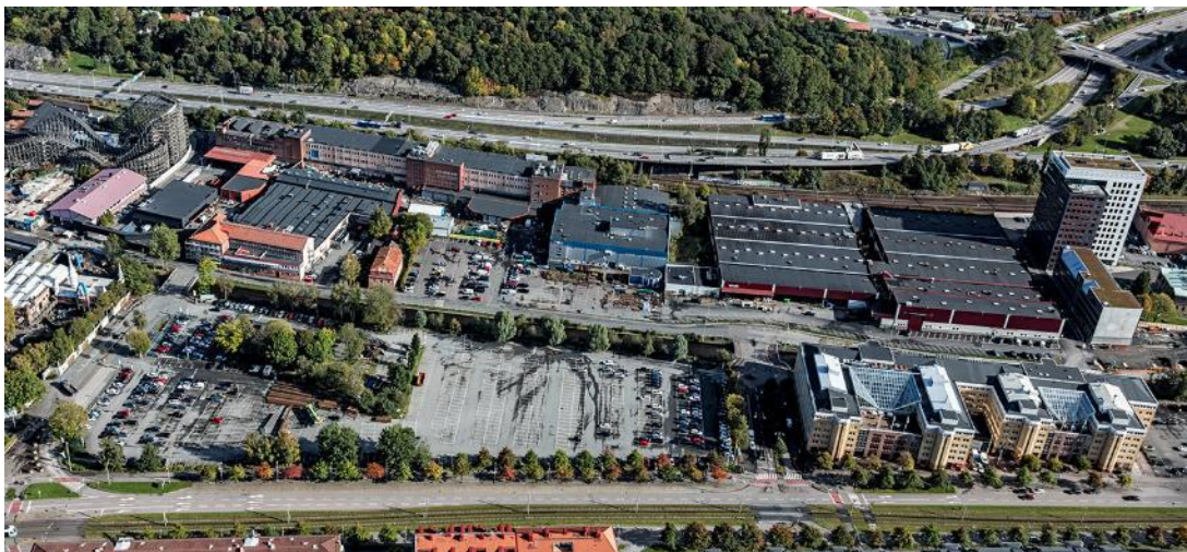
Vyfoto från väster över planområdet idag. Obs! Flera befintliga byggnader har rivits sedan fotot togs.
