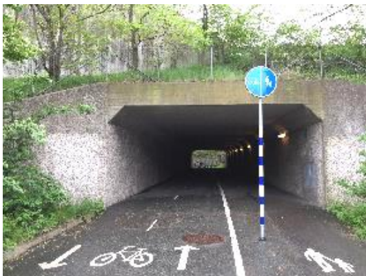
Gång- och cykeltunnel under E6 mot Skår
