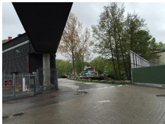
Nellickevägen i korsningen i norr mot söder
